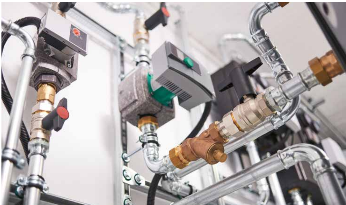
Die Erneuerung von Bauteilen im gemeinsamen Eigentum – wie etwa die Haustechnik – ist im Stockwerkeigentum besonders anspruchsvoll.
