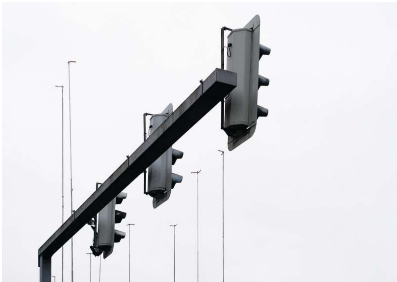
Bauen an lärmigen Strassen bleibt extrem anspruchsvoll.
