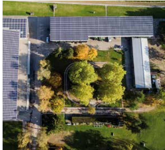
Photovoltaikanlagen, wie diejenige auf dem Horsepark in Dielsdorf (links), bringen ihren Besitzern gemäss Marco Rall von der Solar Alliance AG (unten) auch eine interessante Rendite.
