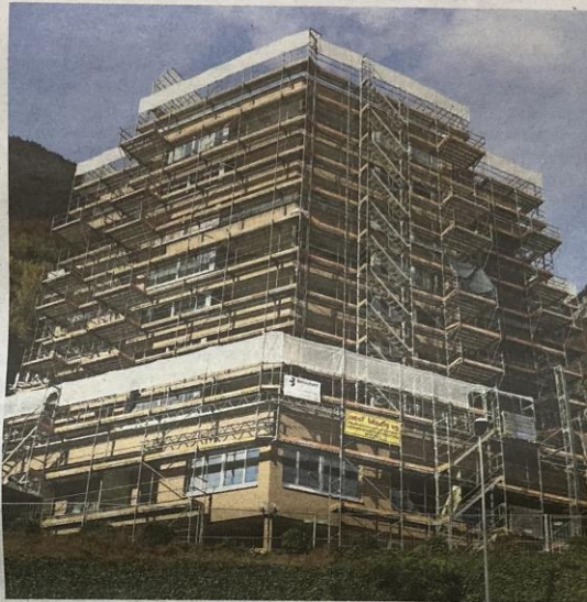
Sanierungen von Gebäuden im Stockwerkeigentum erfordern eine sorgfältige Planung und Absprache innerhalb der Eigentümergemeinschaft (im Bild Sanierung Schiller B in Brunnen). Bild: Nadia von Euw
